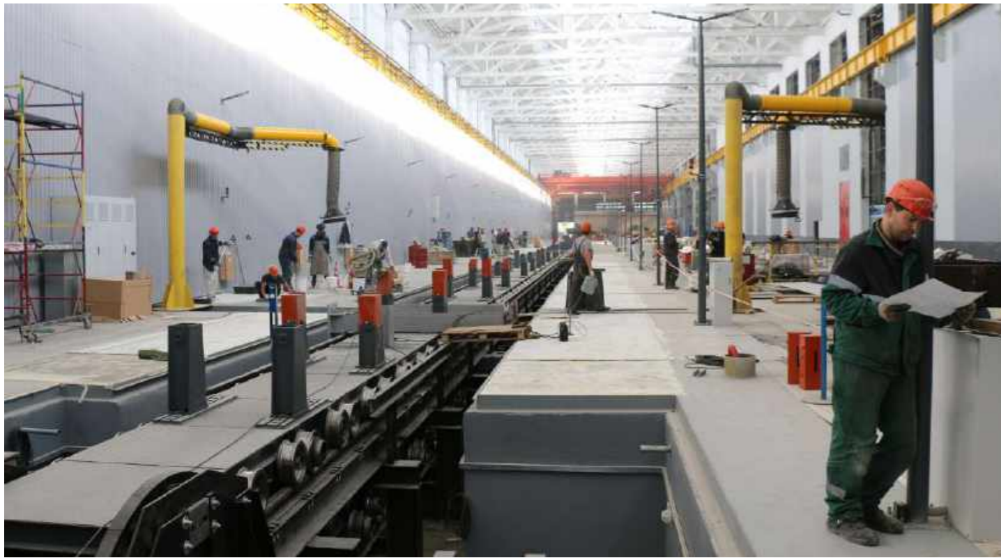
Масштабная реконструкция цеха главного конвейера
